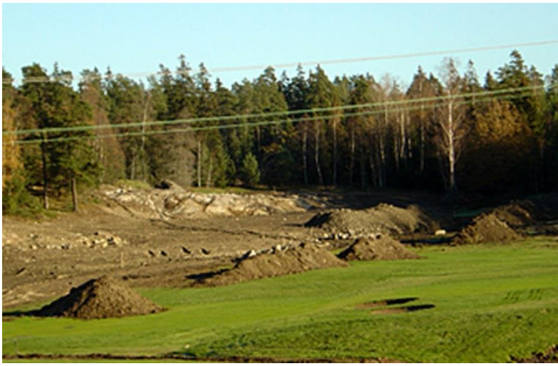
Arbetena med 17:e. Lägg märke till högsänningskablar som numera är ett minne blott.
